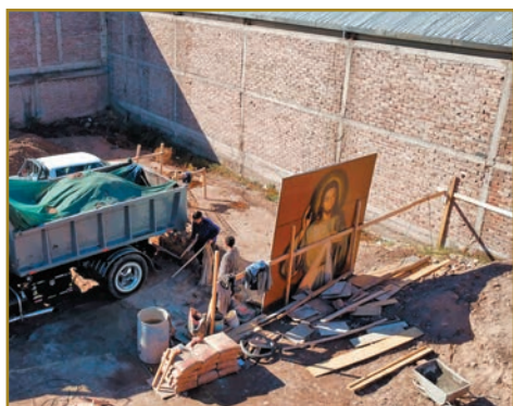
La hna. Norma en momentos de la construcción del santuario.
